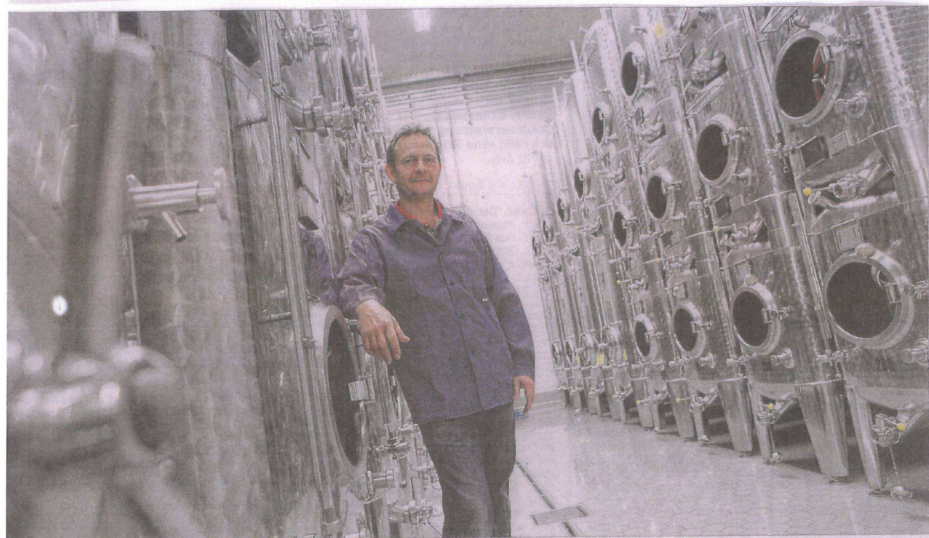
Siegbert Bimmerle vor seiner neuen Investition im Renchener Gewerbegebiet: Manche Gärtanks in der 3000 Quadratmeter großen Halle fassen 750, andere 12000 Liter. Durch die unterschiedliche Größe können Weine individueller vergoren werden.
