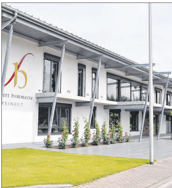
NEUBAU in Renchen: Das Betriebsgebäude war durch das enorme Wachstum des Unternehmens notwendig geworden.
